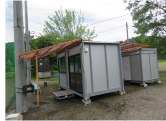
町下球場へ、ユニットハウス・物置設置
